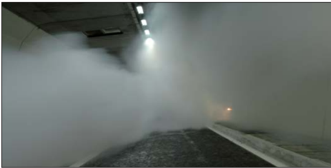
Obr. 10 Zkouška kouřem Fig 10 Smoke test
